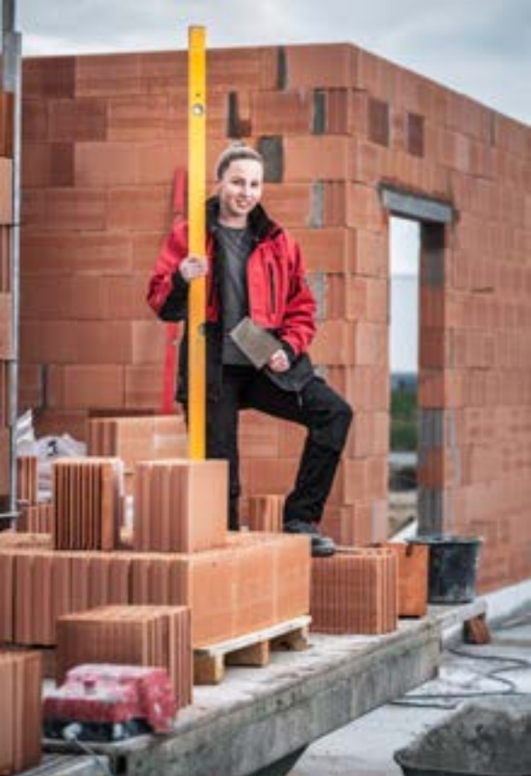
Stein auf Stein und gute Laune: Lea-Marie Kittel macht eine Ausbildung zur Maurerin. Auf der Baustelle am Leinenweg in Verl wird eine Kita für 100 Kinder gebaut.
