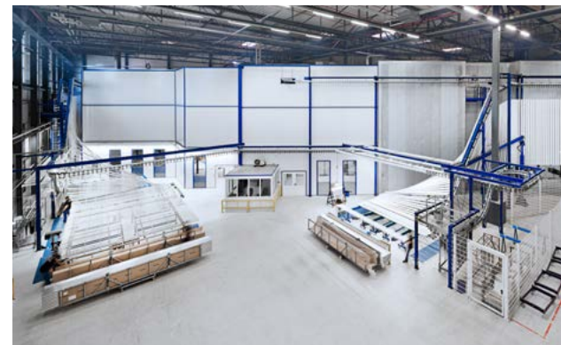
Leistungsstark, effizient und ökologisch: In der Beschichtungstechnologie setzt heroal Maßstäbe. Seit 2012 ist die hochmoderne Vertikal-Pulverbeschichtungsanlage im Werk II in Hövelhof in Betrieb.
