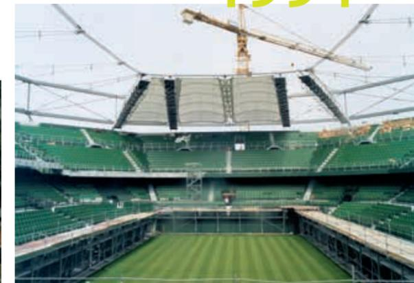
Das Stadion erhält die innovative mobile Dachkonstruktion.
